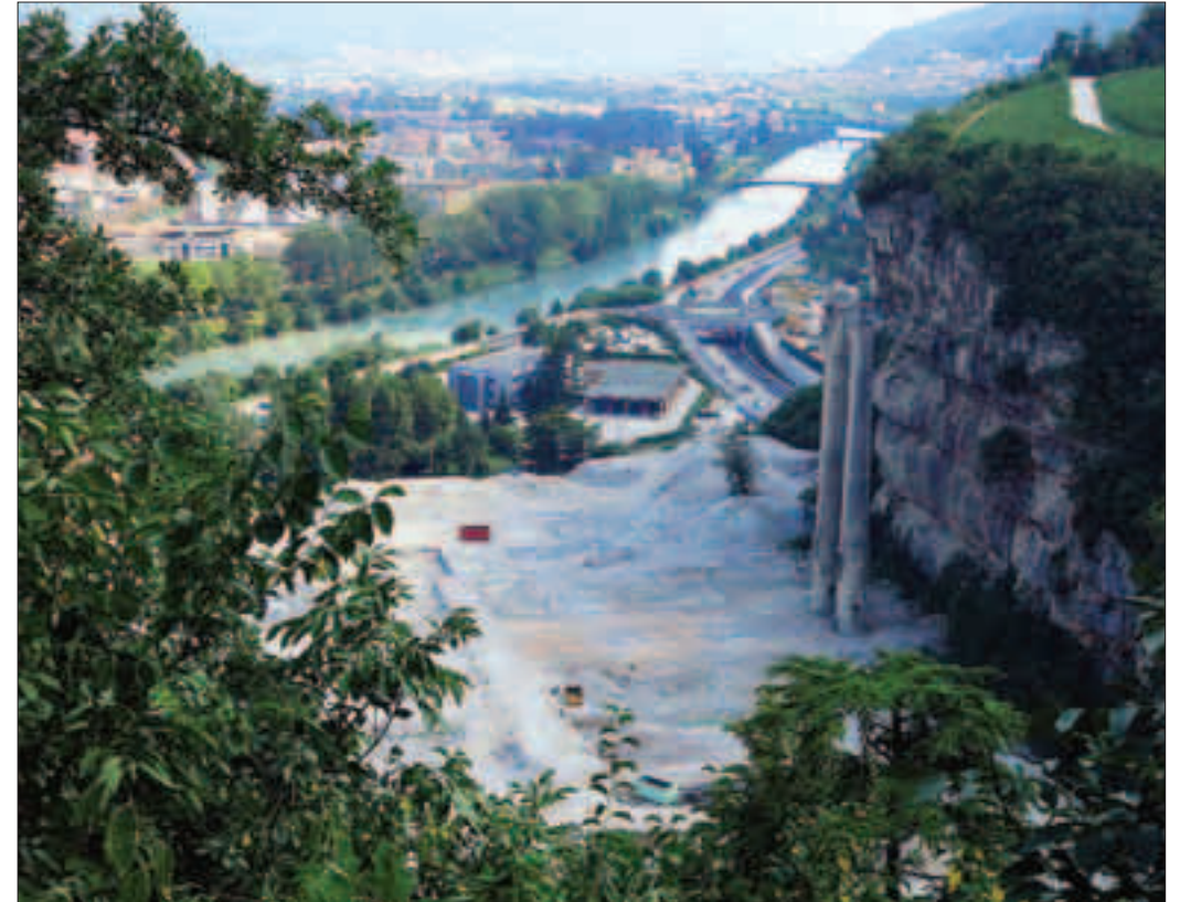
L'area ex Italcementi, oggetto di una permuta tra Cooperazione e Provincia, non ha oggi un progetto definito
